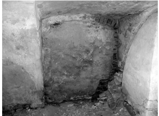
Zamurowany korytarz lub krypta pod nawą północną
