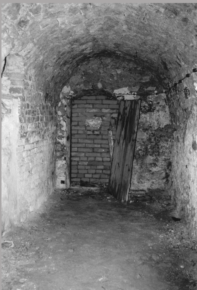
Zamurowane drzwi - wyjście z kościoła do łącznika
