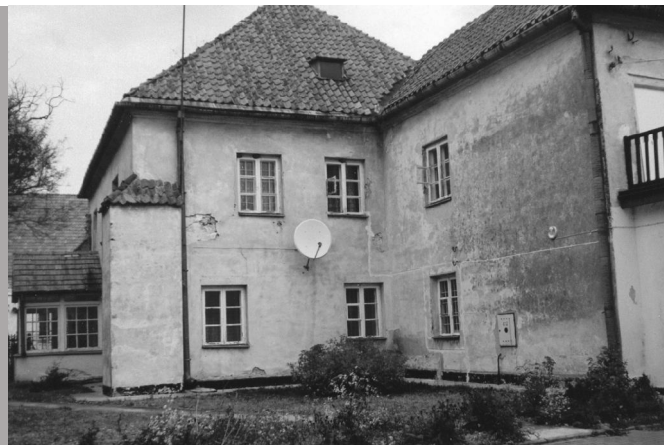
Budynek plebanii - widok od strony południowej
