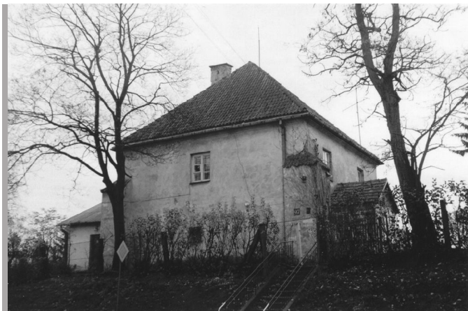
Budynek plebanii, widok od strony ul. Lubelskiej
