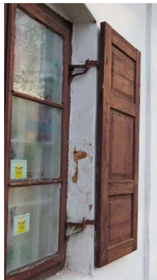
Sposób umieszczenie oryginalnej okiennicy, zawias kowalski na futrynie okna polskiego
