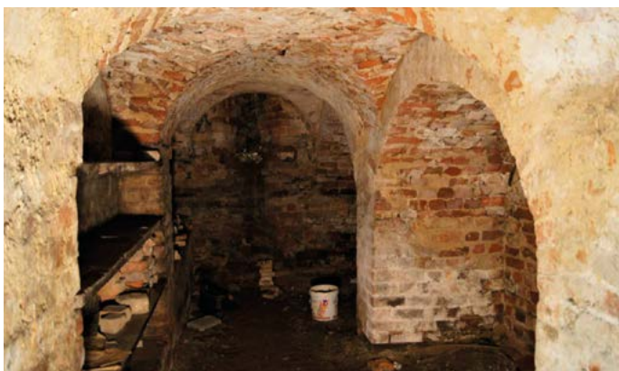
Stan piwnic przed remontem 2012 rok
