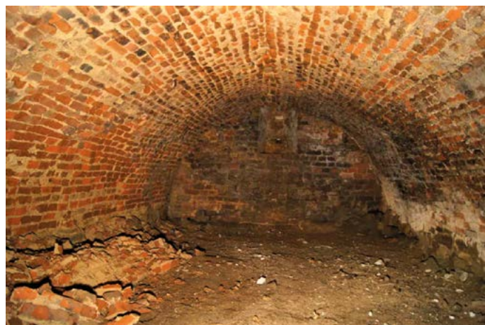
Stan piwnic przed remontem 2012 rok
