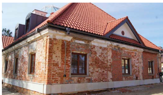
Zdjęcie wykonane w trakcie remontu pokazuje dokonane na przestrzeni lat przebudowy, oraz przywrócenie pierwotnego układu okien
