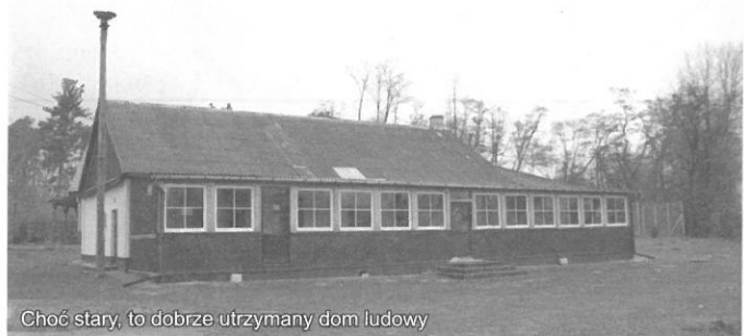
Choć stary, to dobrze utrzymany dom ludowy.
