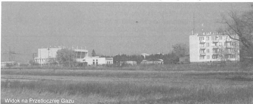
Widok na Przetłocznnię Gazu
