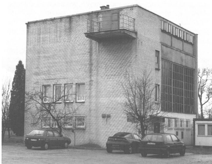
Siedziba GJUK przy ul. Pożowskiej 2 A
