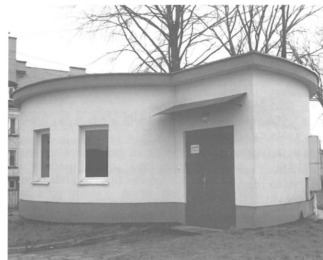
Stacja uzdatniania wody przy ul. Pożowskiej 8
