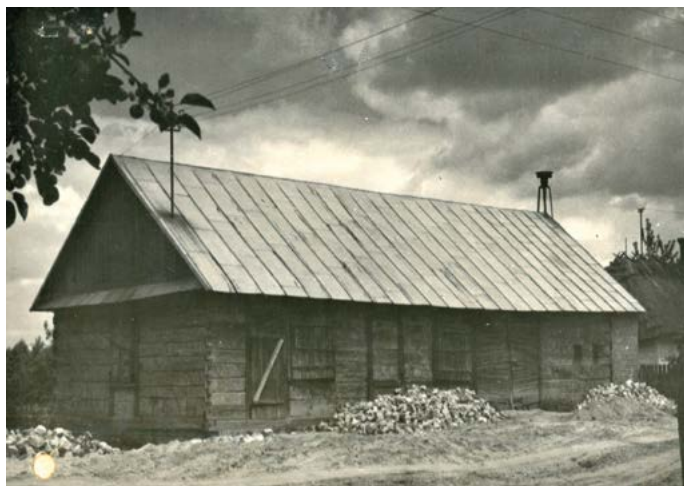
Remiza strażacka wybudowana w latach 30. XX wieku - drewniana, z bali, była kryta strzechą. Po zakończeniu II wojny pokrycie dachu zmieniono na blaszane. Na zdjęciu stan z 1969 r.
