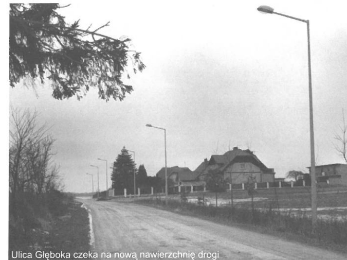
Ulica Głęboka czeka na nową nawierzchnię drogi
