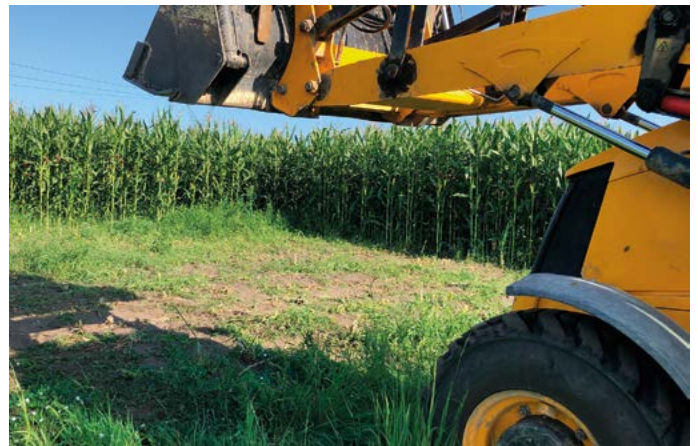
Pierwsze znaleziska, odkryto już po pierwszych zagłębieniach tyżki koparki.
