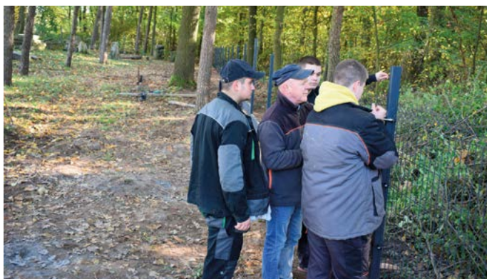
Budowa nowego ogrodzenia cmentarza ewangelicko-augsburskiego (24.10.2023 r.)
