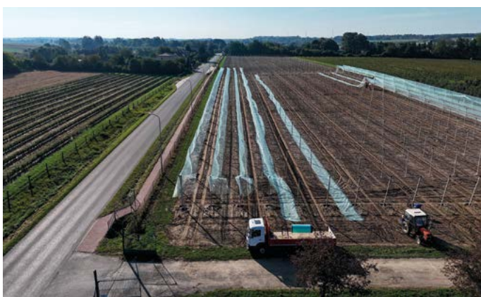
Montaż siatki antygradowej na nowo powstałej kwaterze
