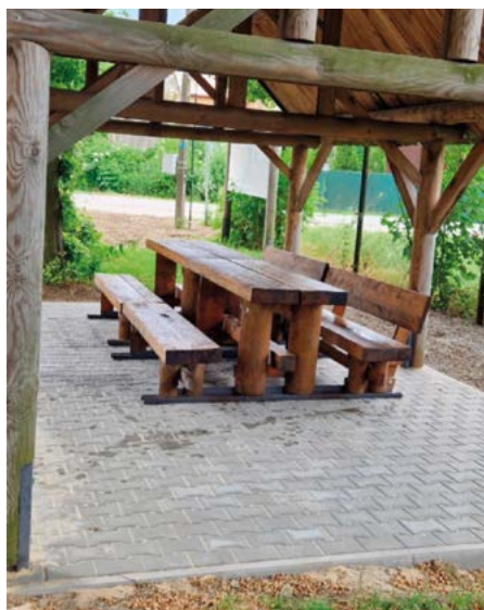
Altana po zakończeniu prac
