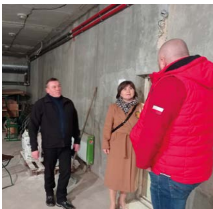
Sala w piwnicach - przed adaptacją
